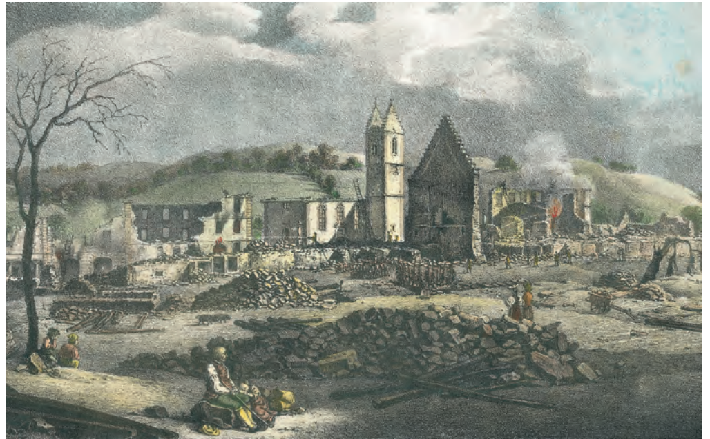
Die Brandstätte des Städtchens Huttwil am Morgen des 9. Juni 1834.
